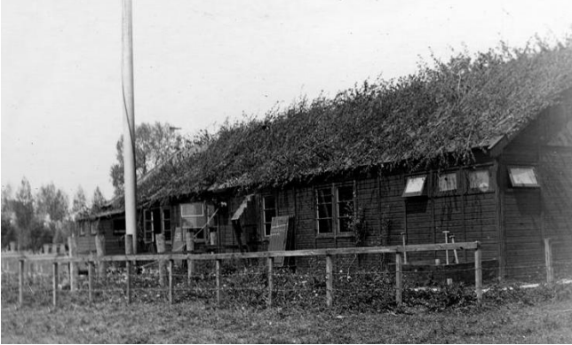
Het dak is voorzien van camouflage om de zichtbaarheid vanuit de lucht te beperken
