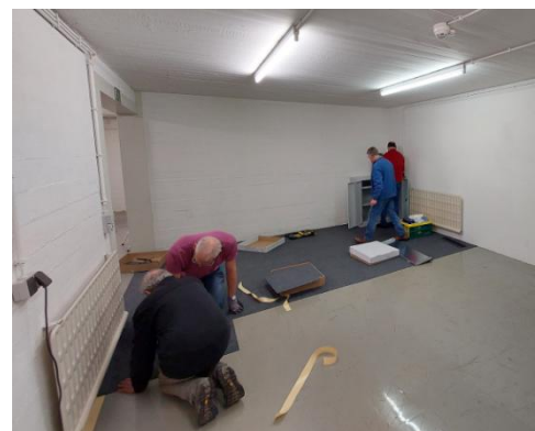
Vloerbedekking leggen in het kantoor
