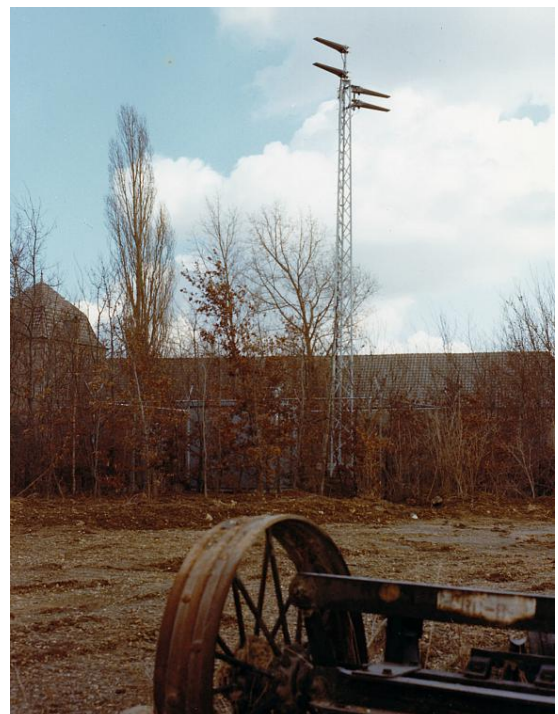
Frequentiewisselaar op de Pietersberg, het gebouwtje met de apparatuur is net zichtbaar tussen de bomen
