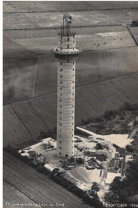
De straalverbindingstoren Loon op Zand in aanbouw
