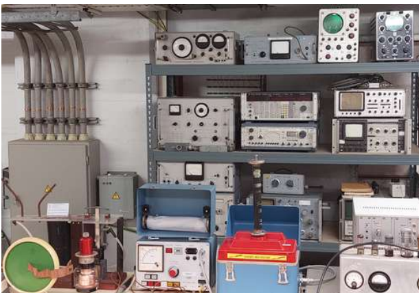
Enkele van de vele test- en meetapparaten
