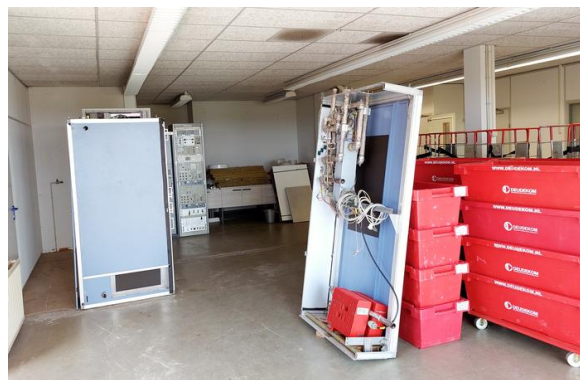
De halve zender rechts moet nog aan de al geplaatste kast links worden geschroefd.
