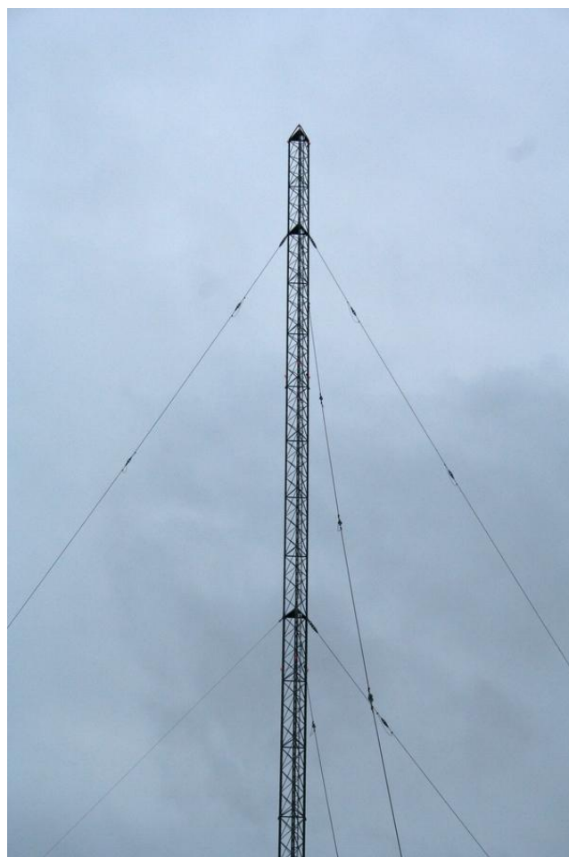
De tui is vervangen door een Kevlar kabel. Deze kabel is zichtbaar dunner dan de stalen tuien.
