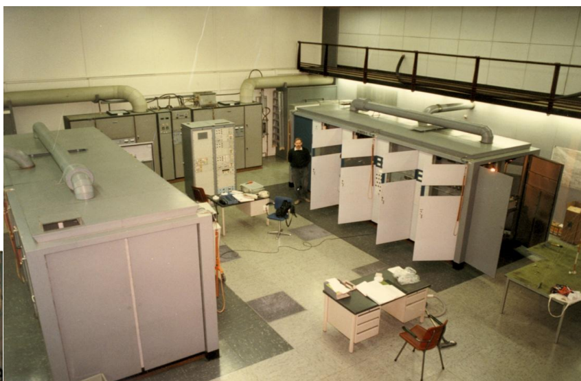
Links (Hvs I) en rechts (Hvs II) staan de twee 120 kW zenders. De rij donkergrijze kasten daar tussen is de Hilversum III zender en de twee kasten daarvoor bevatten de audio- en monitorapparatuur.
