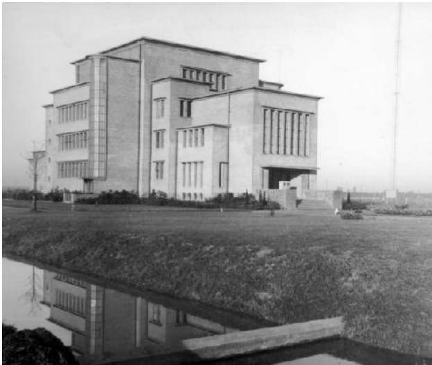
Het Nozema gebouw in vroegere jaren
