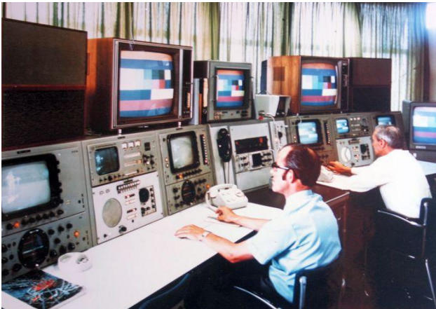
Het tijdelijke bedieningscentrum op de buitenring van de 16e verdieping van de toren in Lopik in 1971. Hiervandaan werden uiteindelijk alle TV zenders, behalve die van Lopik zelf, bedient.
